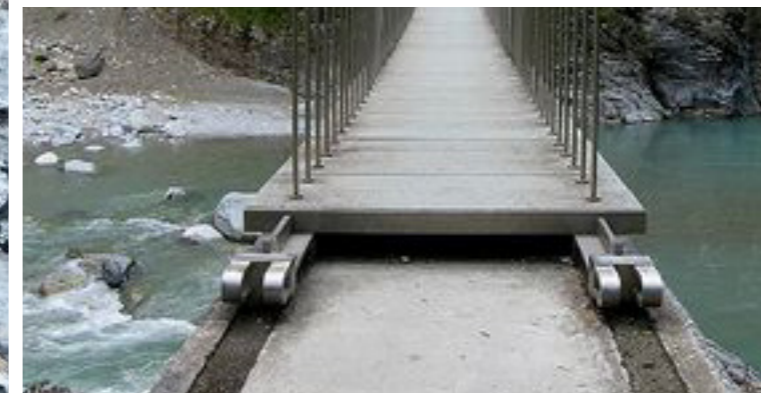
2. Möjligt läge för ny fotgängarbro mellan de två sidorna av Råån vid utrivet dämme. Möjligheten att använda del av befintliga betongfundament kan utredas vidare.
